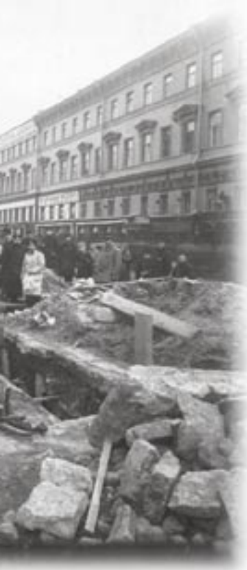
Компаны: повсюду шла прокладка телефонного кабеля
